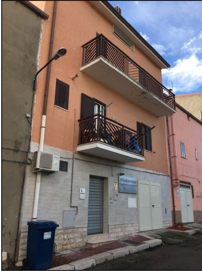
FOTO N. 3 - scattata in data 13-11-2019 Vista esterna dell'immobile ubicato alla Via Papa Giovanni XXIII nel Comune di Castelluccio dei Sauri (FG). Indicato al N.C.E.U. al foglio11 p.lla 467 sub.4-5-6 (ex sub.3).
