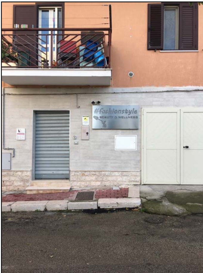
FOTO N. 4 - scattata in data 13-11-2019 Vista esterna dell'immobile ubicato alla Via Papa Giovanni XXIII nel Comune di Castelluccio dei Sauri (FG). Indicato al N.C.E.U. al foglio11 p.lla 467 sub.4-5-6 (ex sub.3).
