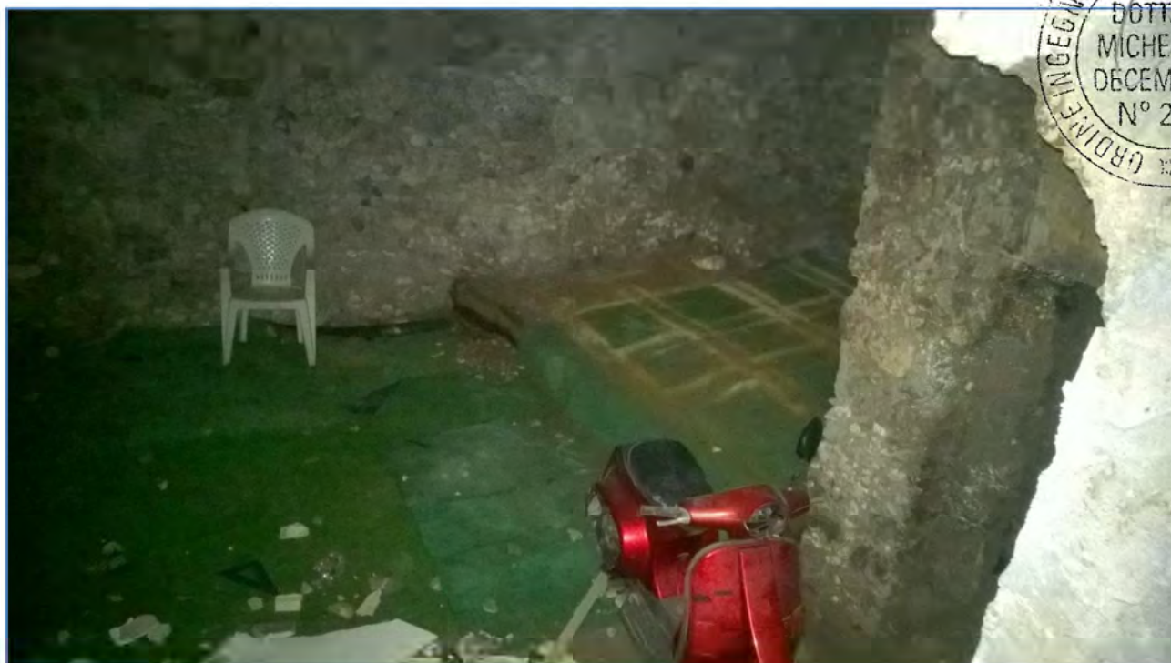
Foto 8: Panoramica da apertura immobile adiacente su lato ingresso
