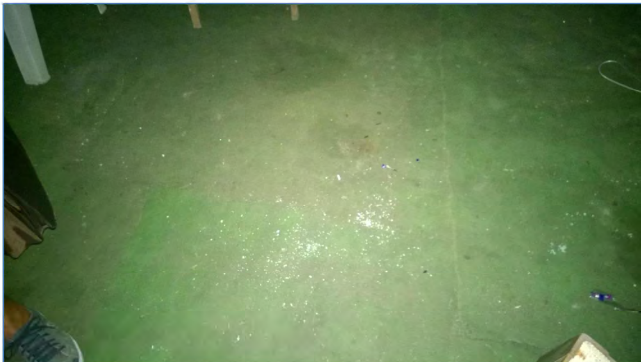
Foto 4: Particolare piano di calpestio
