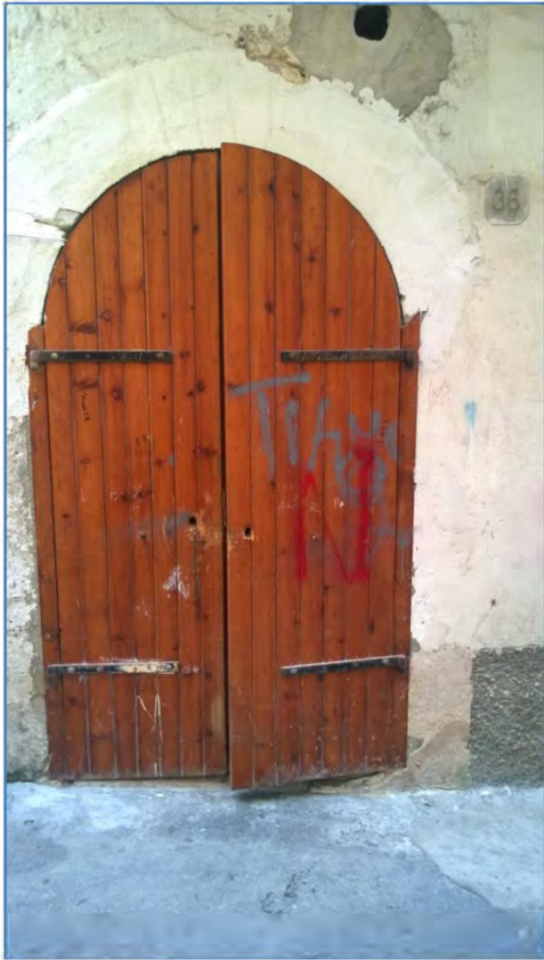
Foto 1: Portoncino di accesso all'immobile oggetto di esecuzione, in Vieste alla via Armando Diaz 36
