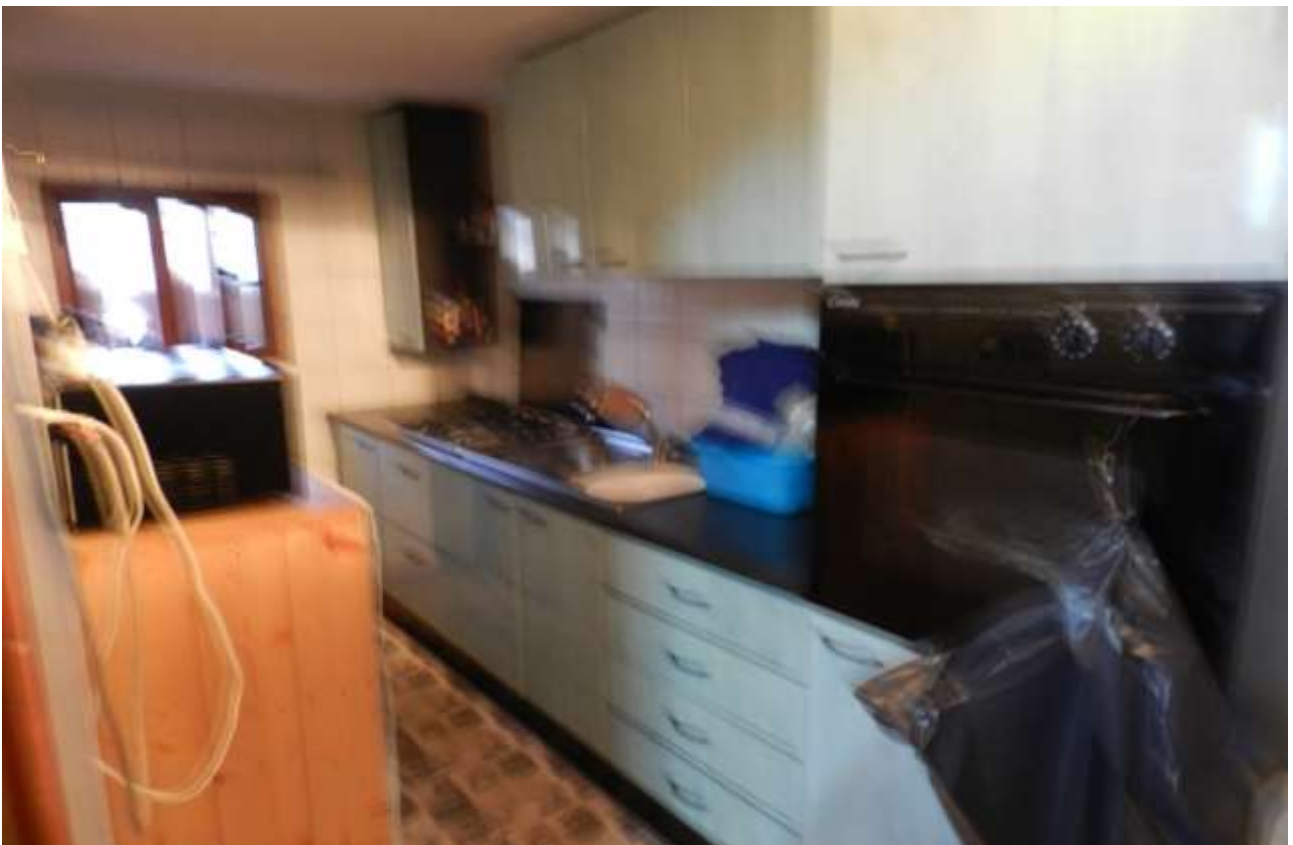
Foto n.12: ripostiglio adibito a cucinino (piano secondo)
