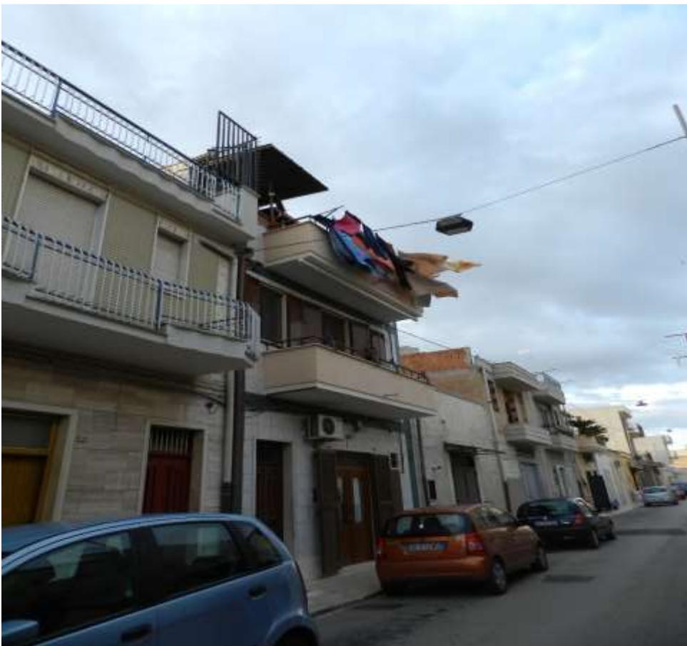
Foto n.2: fabbricato vista laterale
