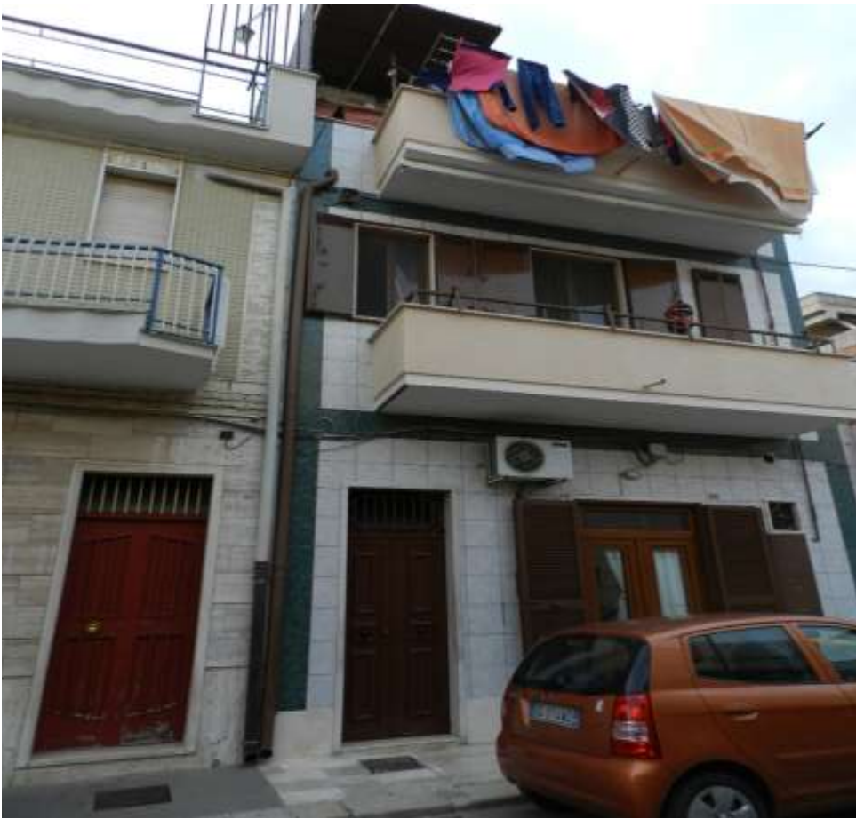
Foto n.3: fabbricato vista frontale
