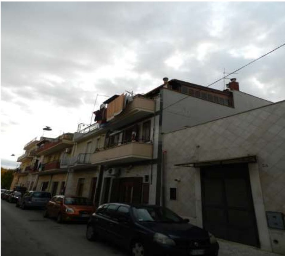
Foto n.1: fabbricato vista laterale
