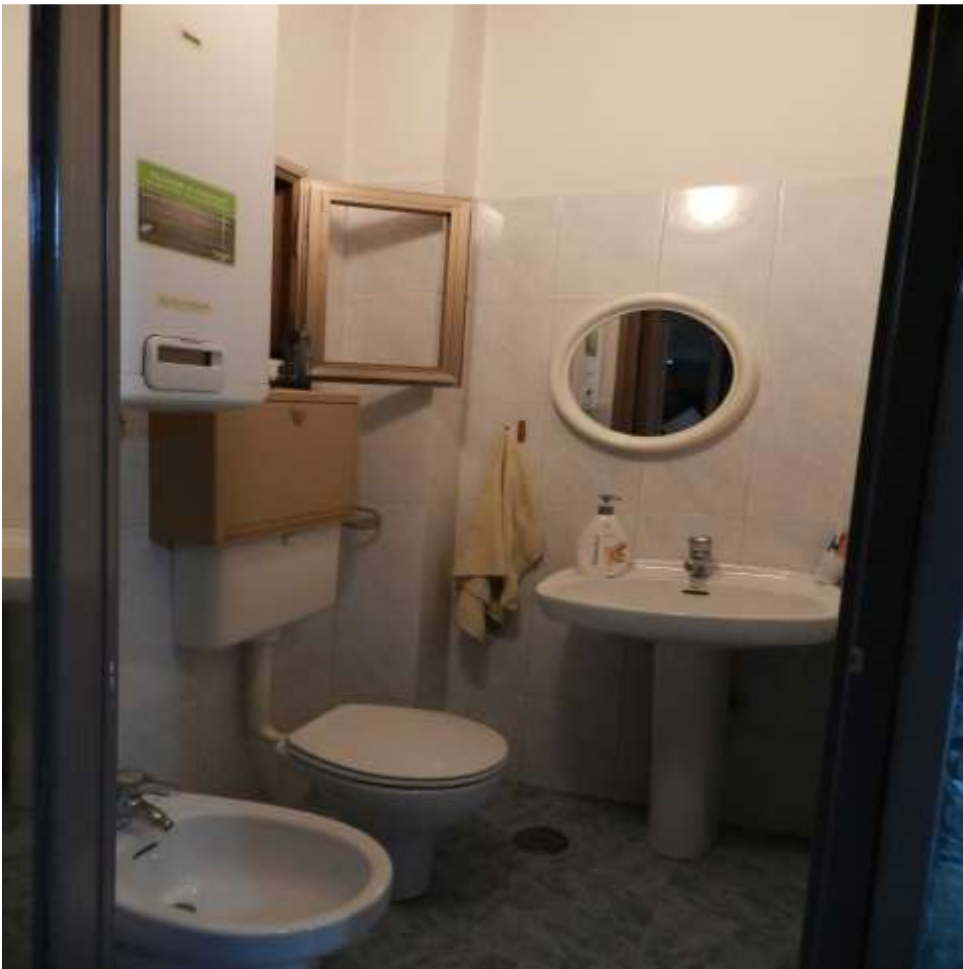
Foto n.11: bagno (piano secondo)
