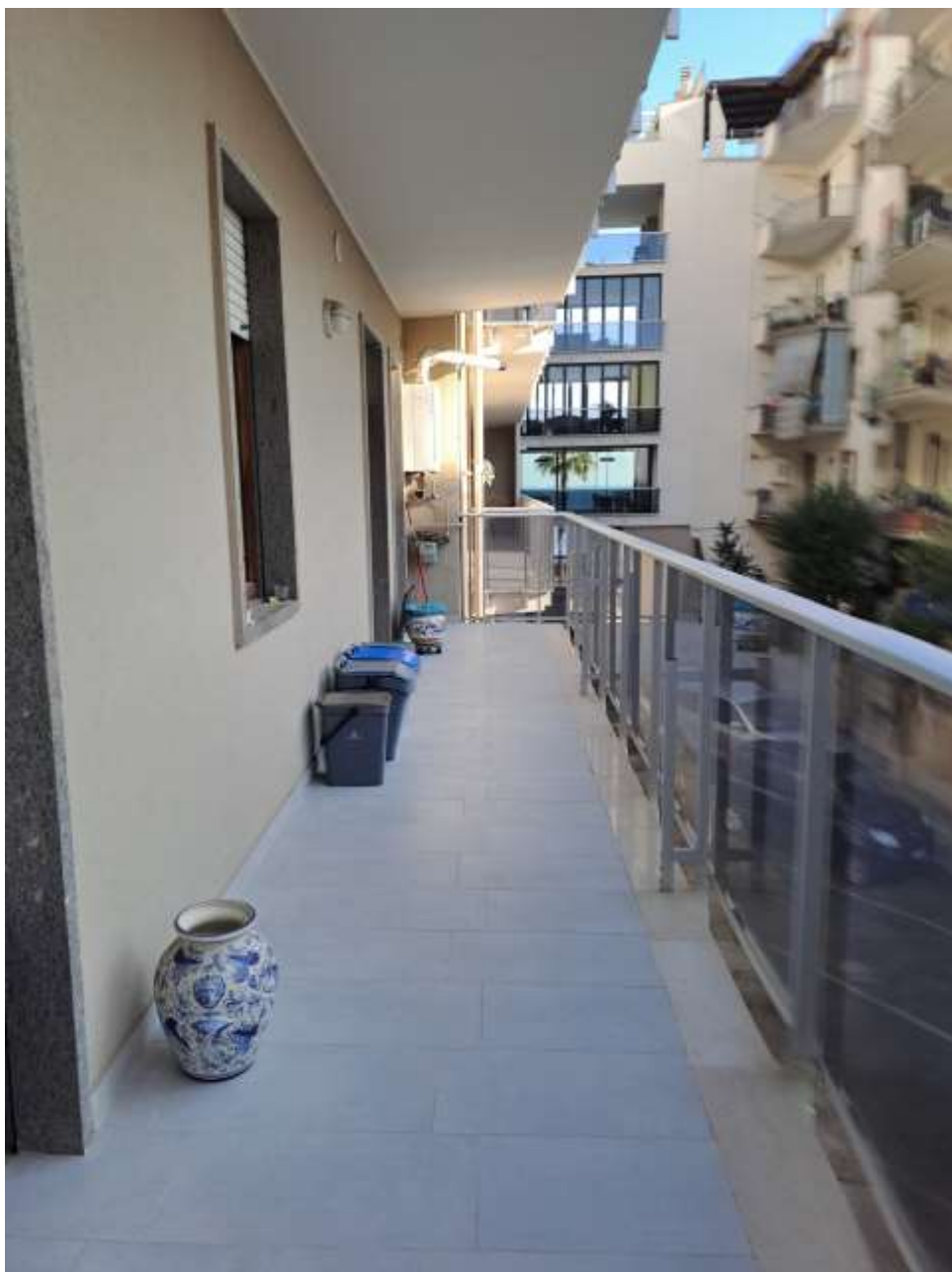
Figura 13 - balcone prospetto lato sud-est
