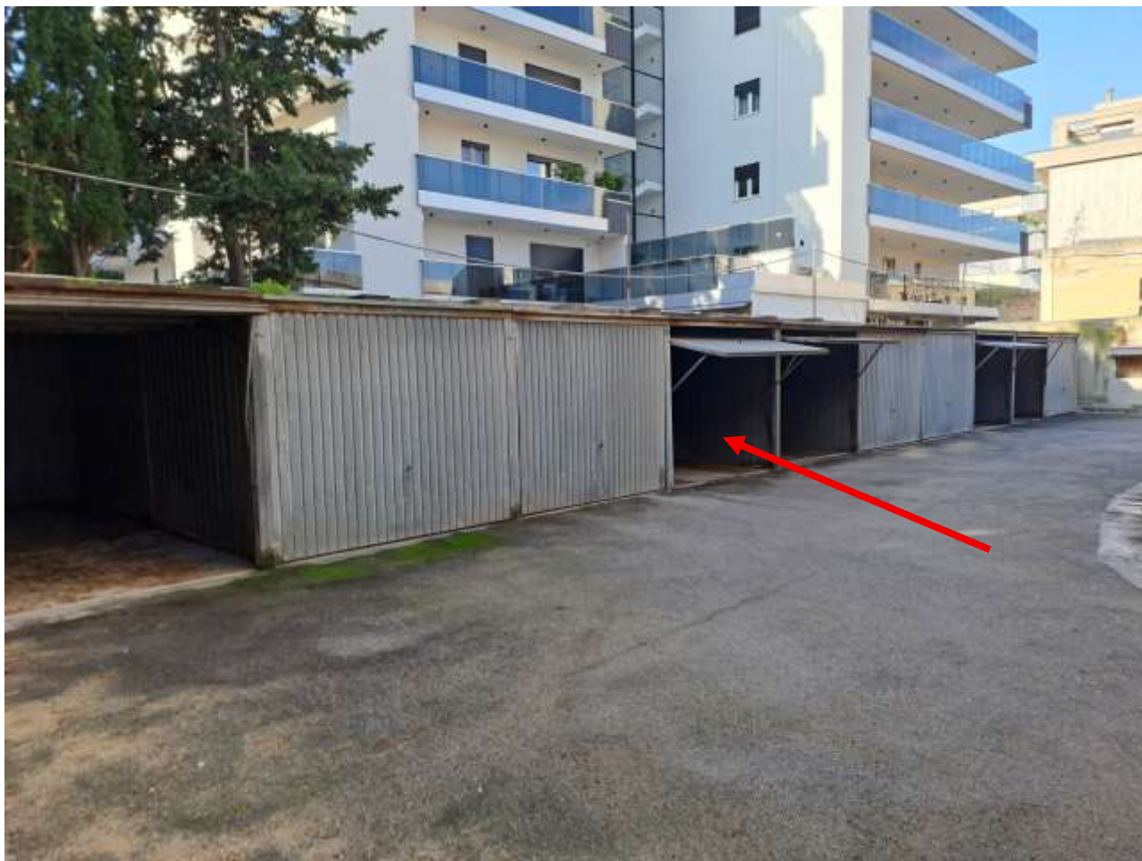
Figura 28 - box metallici impiegati come box auto (con indicazione di quello oggetto di perizia)
