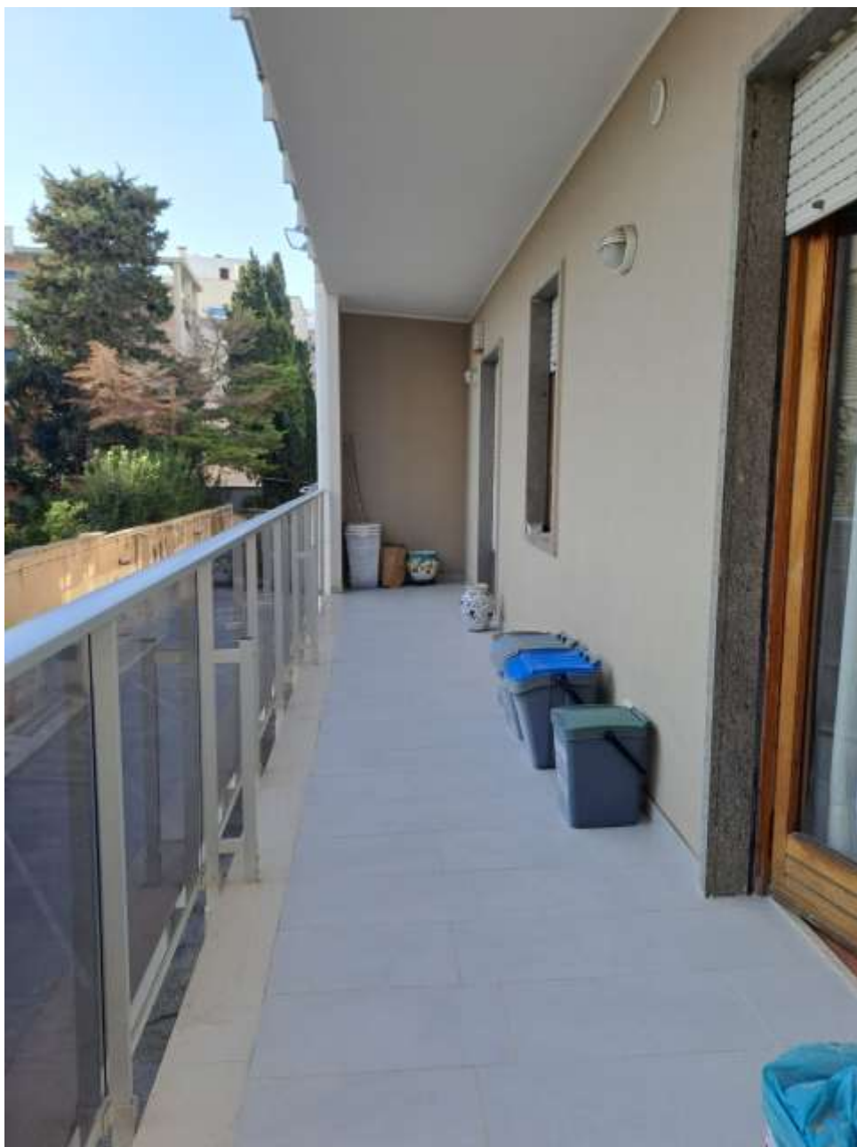
Figura 12 - balcone prospetto lato sud-est
