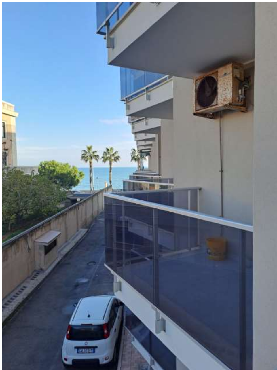
Figura 26 - balcone camera letto matrimoniale (prospetto lato nord-ovest)
