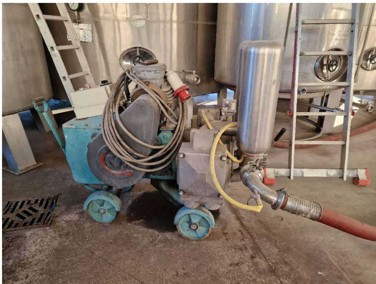
47- POMPE DA TRAVASO
