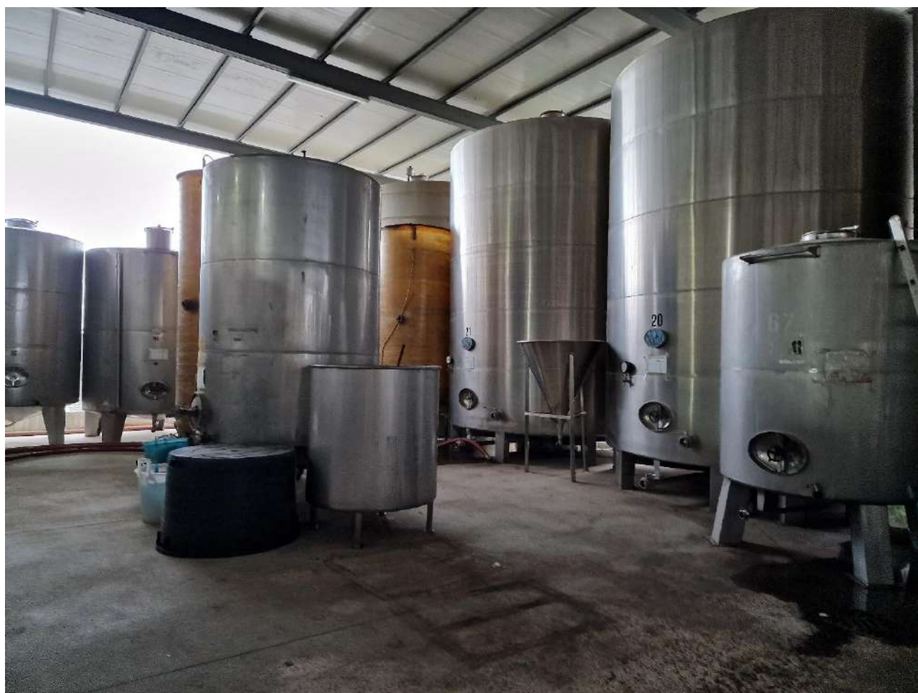
42- SERBATOI DA 170 HL
