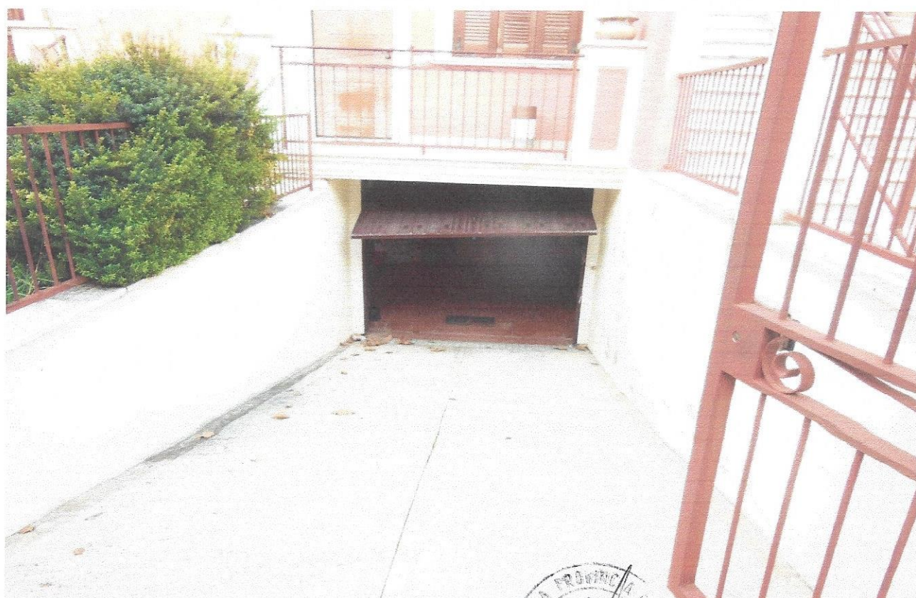
12 – Part. rampa accesso box
