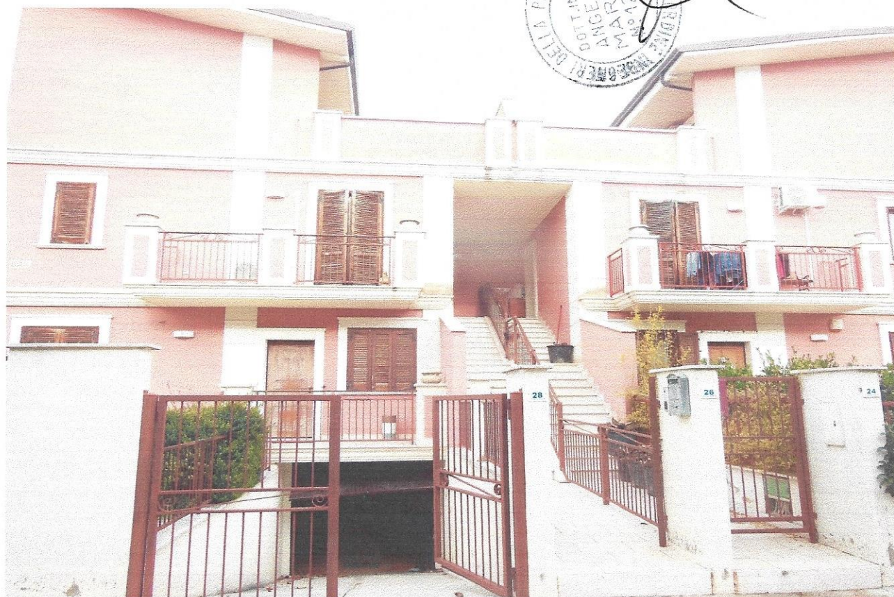
1 – Part. prospetto fabbricato su via delle Mimose
